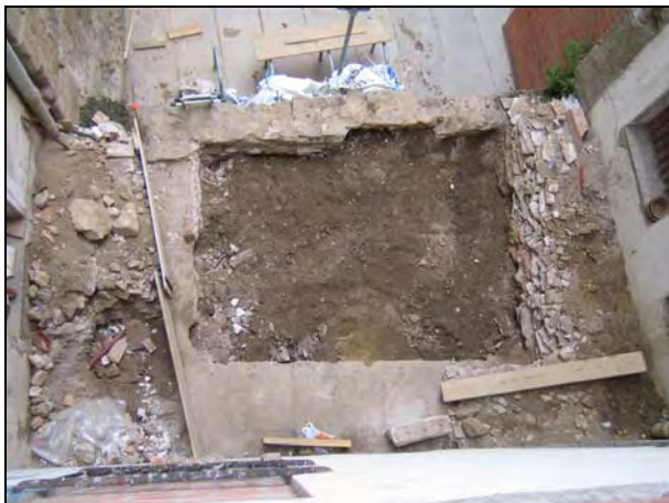
FOTO 71. Cala 4, estat final, rebliment
