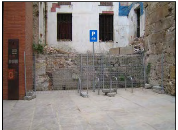
FOTO 72. Cala 4, estat final, col·locació de tanques
