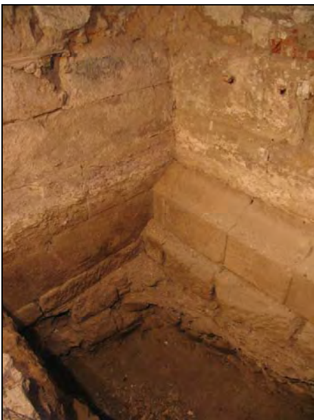
FOTO 3. Cala de la intervenció 033/98. Fonament i filades de la torre núm. 36 i del parament extern de la muralla
