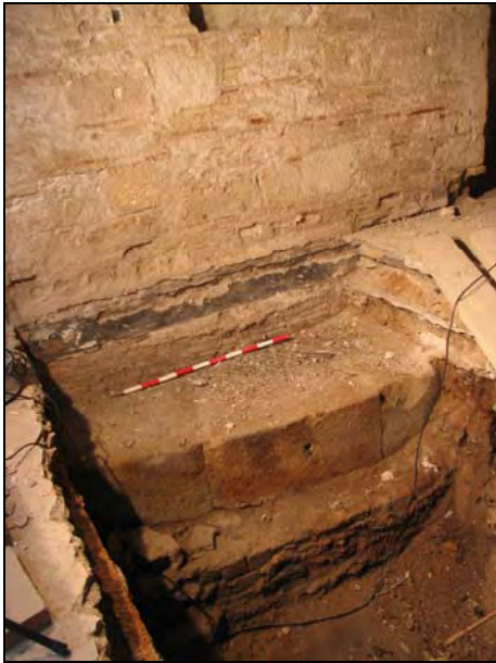
FOTO 1. Cala de la intervenció codi M.H.C.B. 033/98. Fonament i primera filada torre núm. 37
