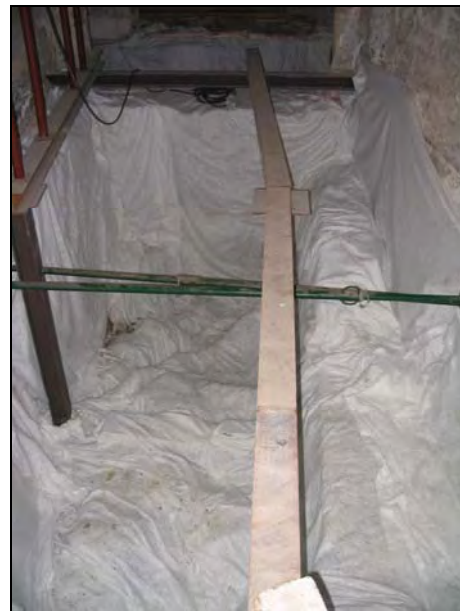
FOTO 4. Col·locació de geotèxtil a les cales de la intervenció de 1998.
