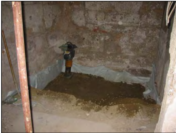
FOTO 5. Rebliment amb sauló i compactació de les cales de la intervenció de 1998
