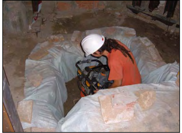
FOTO 26. Cala 2, procés de rebliment, compactació de sauló
