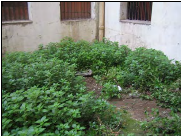
FOTO 35. Cala 4, estat previ
