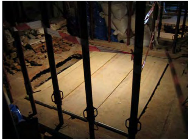
FOTO 18. Cala 1, estat final, condicions de seguretat
