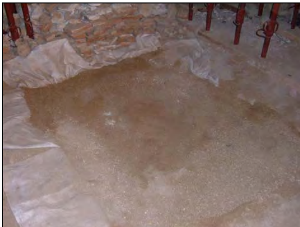
FOTO 19. Cala 1, geotèxtil i sauló compactat
